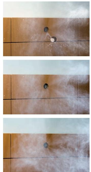
Der mittels einem Druck von 10 bar erzeugte Wassernebel füllt den Raum in Sekundenschnelle, nachdem die Schutzkappe fortgeschleudert wurde.
